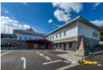
南丹市役所 中央庁舎 所在地: 京都府南丹市園部町 構造・階数: S造・2階 延床面積: 2,069㎡
