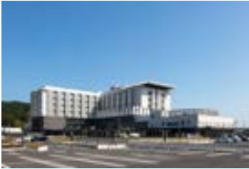
島田市立総合医療センター 所在地: 静岡県島田市野田 構造・階数: SRC(一部)造・8階/B1階 延床面積: 38,285㎡【445床】
