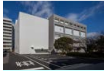
広島大学(霞) 動物実験棟 所在地: 広島県広島市南区霞 構造・階数: S造・5階 延床面積: 1,503㎡
