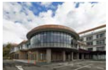
介護老人保健施設 たてやま 所在地: 千葉県館山市北条 構造・階数: RC造・2階 延床面積: 3,275㎡
