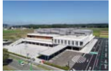
菊陽町総合体育館 所在地: 熊本県菊池郡菊陽町 構造・階数: RC(一部)造・2階 延床面積: 8,713㎡
