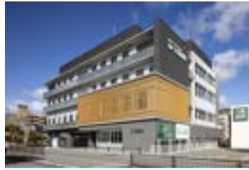
医療法人善正会 上田病院 所在地: 大阪府豊中市稲津町 構造・階数: S造・5階 延床面積: 4,779㎡【94床】
