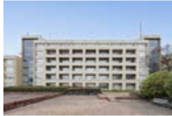
滋賀医科大学 基礎研究棟 所在地: 滋賀県大津市瀬田月輪町 構造・階数: RC造・6階 延床面積: 6,650㎡(耐震補強、内部・外部全面改修)
