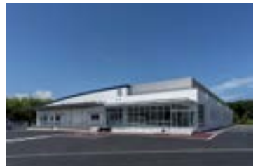
美馬市学校給食センター 所在地: 徳島県美馬市脇町 構造・階数: S造・1階 延床面積: 1,653㎡
