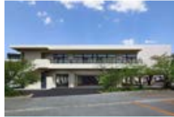
医療法人新社会高田中央病院介護医療院 所在地: 大分県豊後高田市新地 構造・階数: RC造・2階 延床面積: 2,714㎡【50床】
