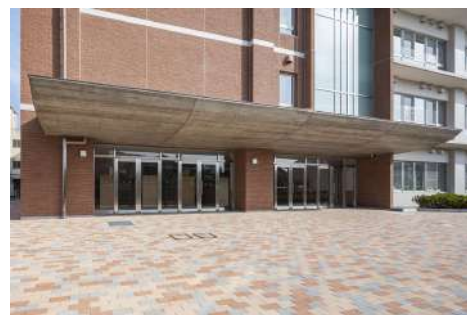
アプローチ・南昇降口
