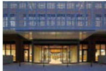
市民広場より庁舎エントランスを見る（夜景）
