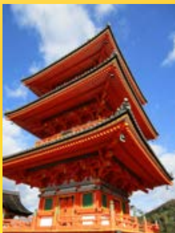
「三重塔（重要文化財）」西門の先に建つ高さ31メートルの塔。1987年に解体修理が完成し、外部の極彩色が復元されました。
