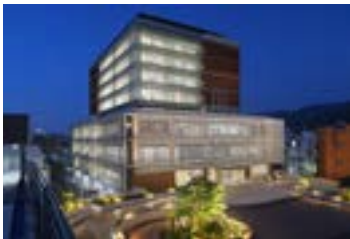
南西面外観（夜景）
