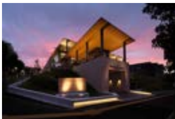
まちなかりビング北千里 所在地:大阪府吹田市古江台 構造・階数:RC(鉄)W・PC・7(木)造・2階/B1階 延床面積:3,070㎡
