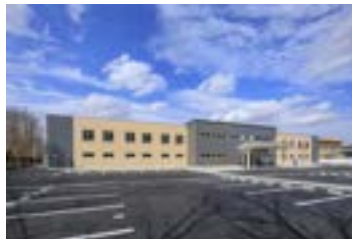
障害者支援施設ひまわりの丘 いきいき・すまいる棟 所在地:岐阜県関市桐ヶ丘 構造・階数:S造・2階 延床面積:5,051㎡
