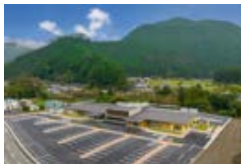
東栄町保健・医療・福祉複合施設 東栄ひだまりプラザ 所在地:愛知県設楽郡東栄町 構造・階数:W造・1階 延床面積:2,407㎡
