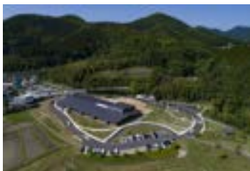
京丹波町立たんばこども園 所在地:京都府船井郡京丹波町 構造・階数:W造・2階 延床面積:2,341㎡
