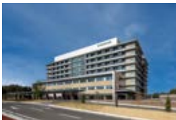
岡波総合病院 所在地:三重県伊賀市上之庄 構造・階数:S造・9階 延床面積:35,006㎡【335床】
