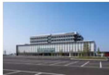
埼玉県済生会加須病院 所在地:埼玉県加須市礼羽 構造・階数:S(鉄)造・7階 延床面積:23,209㎡【304床】
