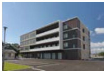
特別養護老人ホーム青香園 所在地:徳島県徳島市川内町 構造・階数:S造・4階 延床面積:3,035㎡
