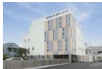
博慈会腎クリニック 所在地:東京都足立区鹿浜 構造・階数:S造・4階 延床面積:1,854㎡【70床】
