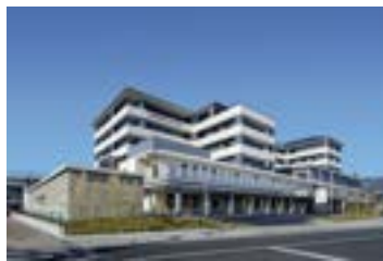
京都済生会病院 所在地:京都府長岡京市下海印寺下内田 構造・階数:S造・7階 延床面積:24,719㎡【288床】
