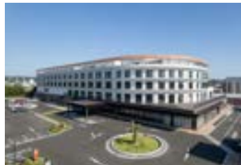
医療法人徳洲会 館山病院 所在地:千葉県館山市北条 構造・階数:S造・5階 延床面積:17,631㎡【222床】
