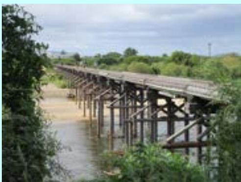
上津屋橋（こうづやばし）は、昭和二十八（一九五三）年三月に架設され、昭和三十四（一九五九）年に一般府道八幡城陽線として認定され、現在に至っています。上津屋橋のある地区は、江戸時代から明治の中頃まで木津川を挟んで上津屋村と呼ばれ、八幡の石清水八幡宮に参拝する人たちも渡し船を利用して木津川を往来していました。しかし渡し船では不便と、地元の強い要望で上津屋橋が完成しました。流れ橋の構造で作られた上津屋橋は、全長356・5メートル、幅3・3メートル、歩行者と自転車・二輪車が通行可能です。この橋の最大の特徴は、大雨で川が増水すると橋桁が水面に浮き、筏のように流れることで水の圧力を受け流し、橋全体の崩壊を防ぎます。橋桁と橋板はワイヤーロープでしっかりと橋脚に繋がれているため流されません。ロープを引き上げ橋脚の上に戻すことができます。
