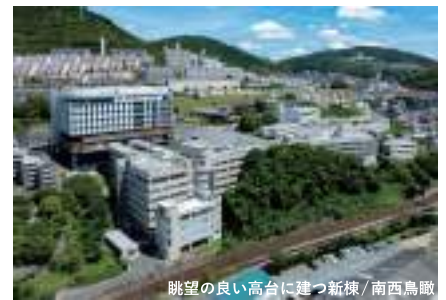
眺望の良い高台に建つ新棟 / 南西鳥瞰
